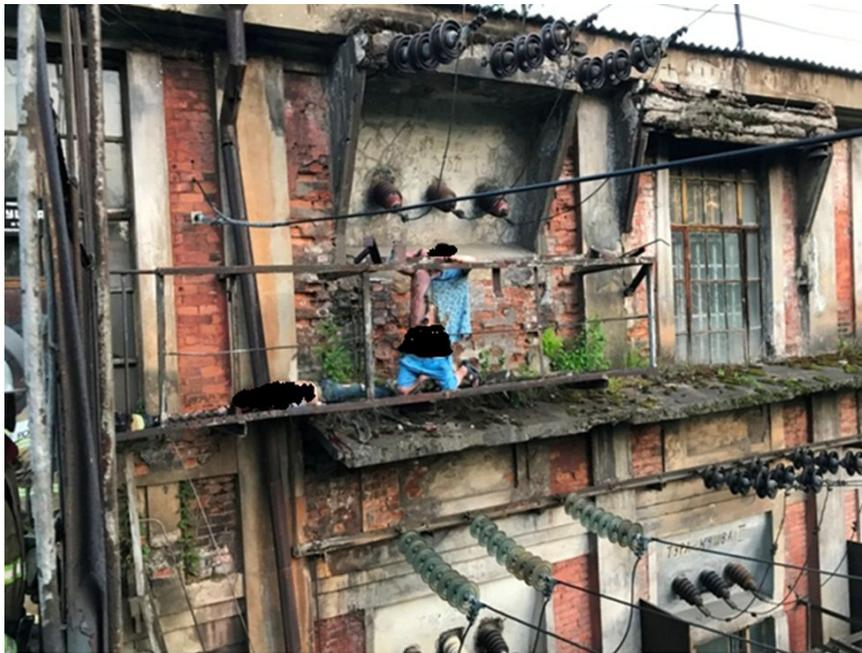
Групповой несчастный случай. Пострадавшие подростки, путем обхода заваренной двери по металлоконструкциям, расположенным на высоте 3-го этажа, перелезли с канатного подвесного моста на площадку обслуживания проходных изоляторов ВЛ 35 кВ, приблизившись на недопустимое расстояние к токоведущим частям на расстояние менее допустимого и попали под напряжение
