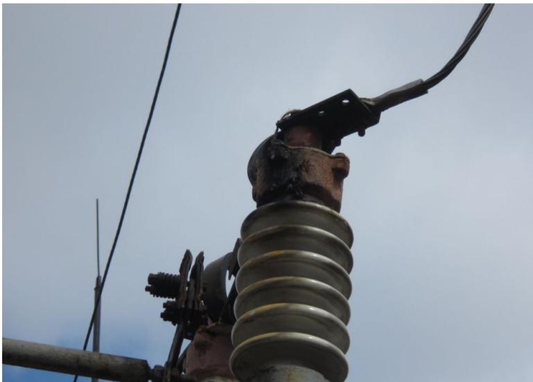
Девочка-подросток (11 лет), играя с другими детьми в прятки, проникла на территорию ПС, сумев проползти под въездными воротами, затем, поднявшись по металлической стойке на раму разъединителя 35 кВ, коснулась головой верхнего оголовника изолятора разъединителя и была поражена электрическим током.
